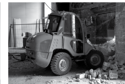
Schweres Gerät für den Abbruch
