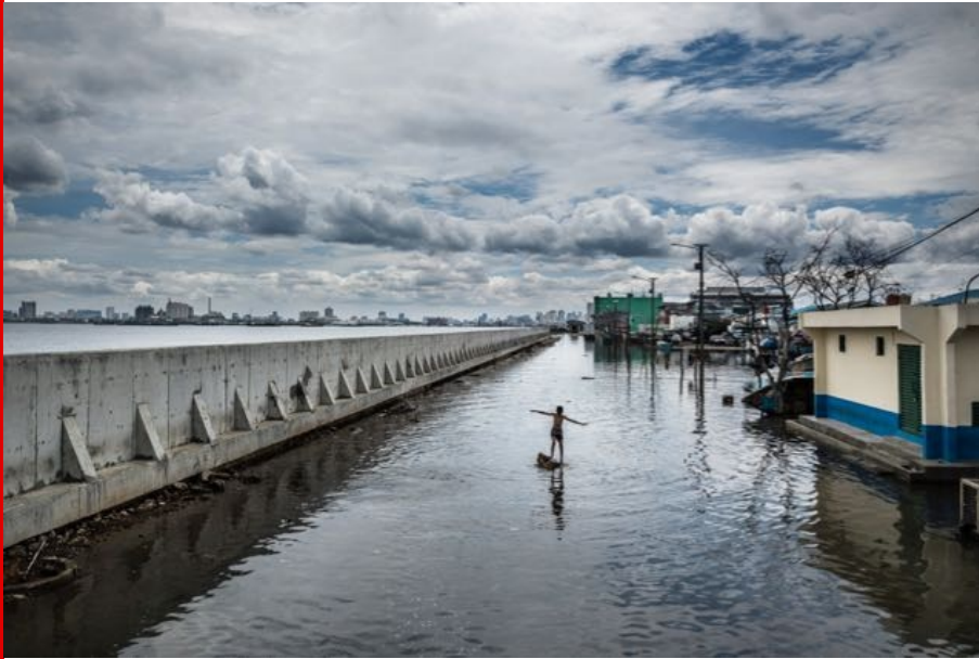
Abb.: Kadir van Lohuizen, Die neugebaute Ufermauer funktioniert nicht wirklich, Jakarta, Indonesien, 24. Dezember 2018
